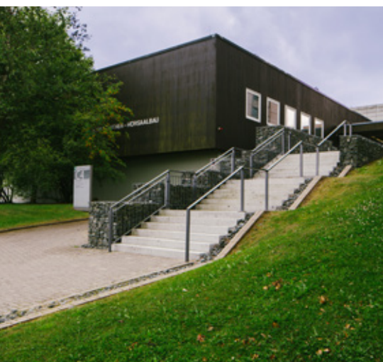
Wird saniert: der Horst-Luther-Hörsaalbau.
