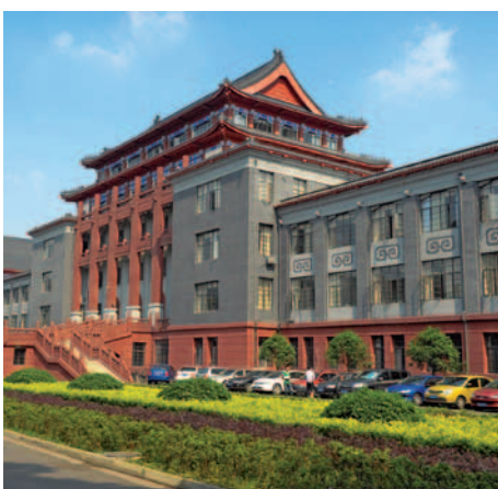
Hauptgebäude der Sichuan University.
