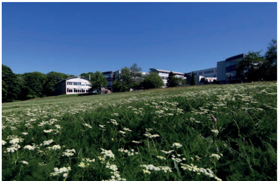
Das CUTEC-Gebäude liegt idyllisch auf dem Clausthaler Campus Feldgraben.
