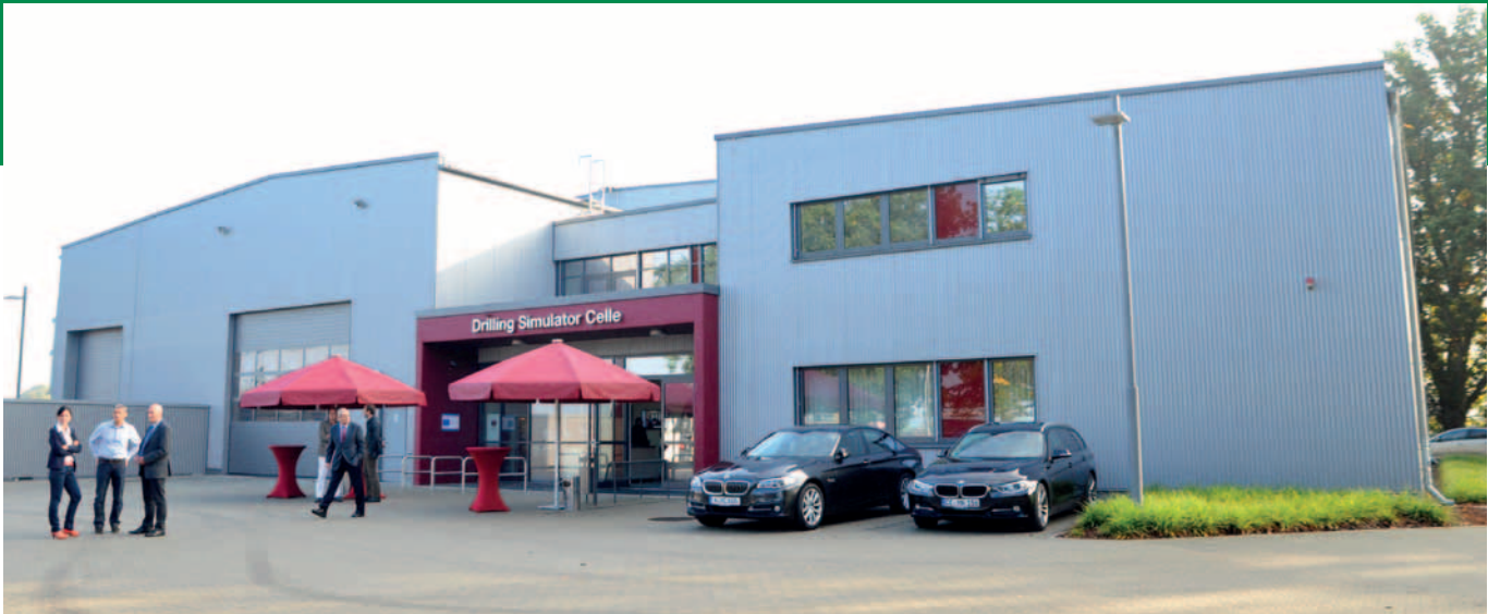
Forschungseinrichtung der TU Clausthal am Standort Celle: der Drilling Simulator.
