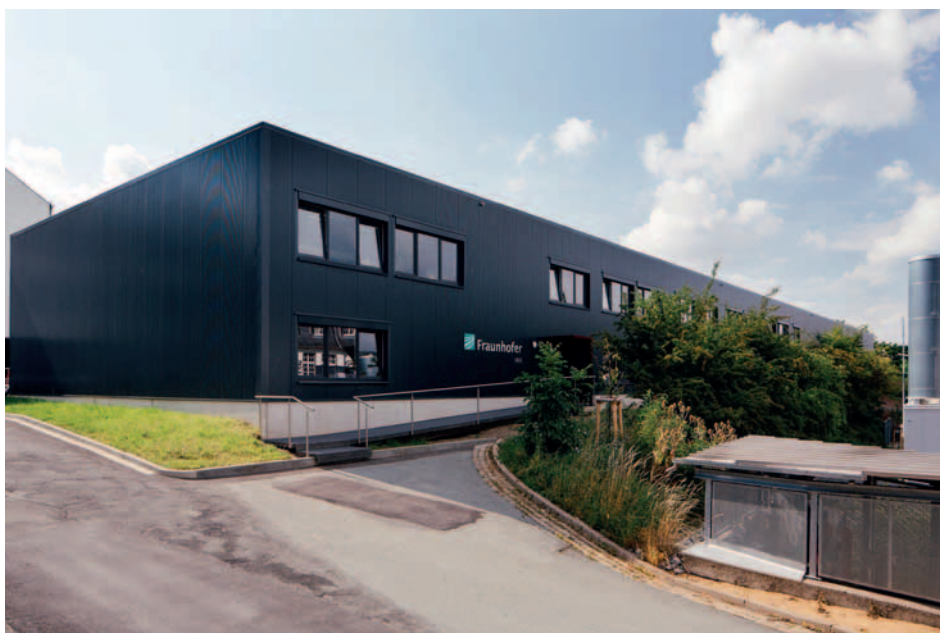
Batterie- und Sensoriktestzentrum auf dem EnergieCampus der TU Clausthal in Goslar.
