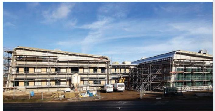
November 2012: Die Arbeiten kommen gut voran.
