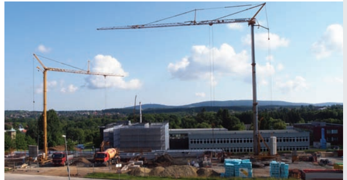
Sommer 2012: Die Hochbauarbeiten beginnen.
