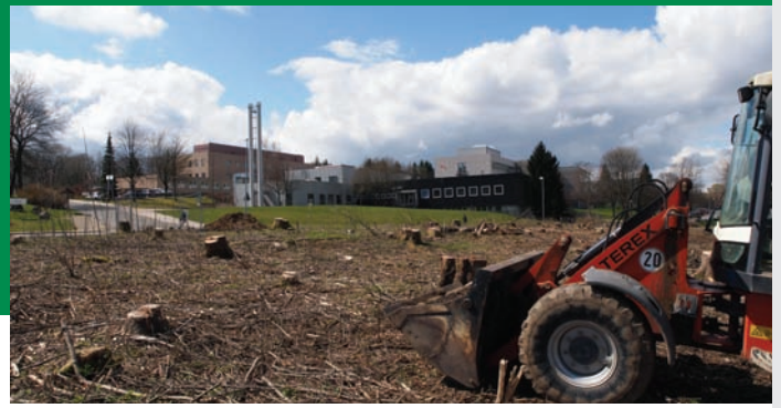
April 2012: Beginn der Rodungsarbeiten für das neue Gebäude.
