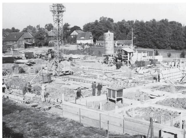
Bauarbeiten zur Clausthaler Universitätsbibliothek Anfang der 1960er Jahre im Feldgrabengebiet.
