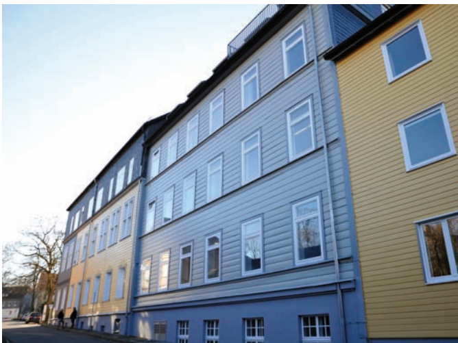
Frisch gestrichen: Fassade des TU-Gebäudes (Graupenstraße).
