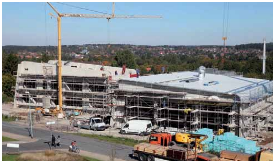
Rohbau des Clausthaler Zentrums für Materialtechnik.
