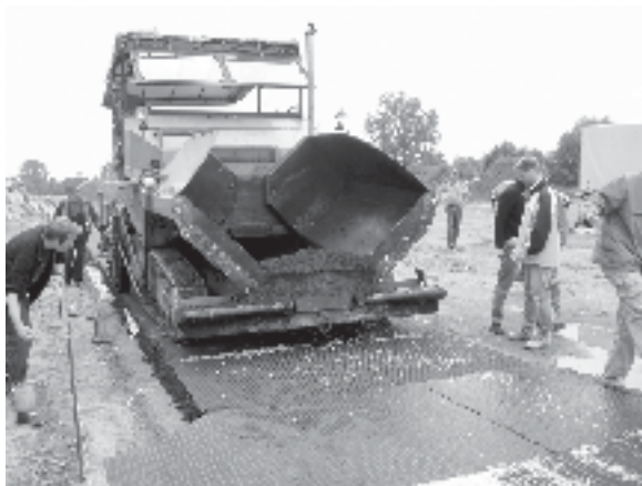
Herstellung einer Teststraße in Langenhagen
