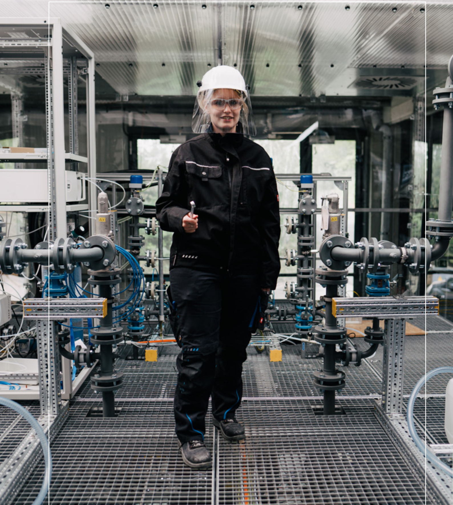
Dr. Stina Bauer ist eine der Forschenden am Elektrolyse-Testfeld, das am 6. Oktober 2022 auf dem Gelände des Forschungszentrums Energiespeichertechnologien in Coslar eröffnet wurde.
